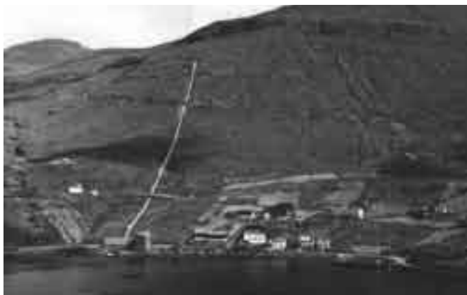
Fossáværket skulle give billig energi til det færøske samfunds gryende industri. Med en faldhøjde på over 200 m blev der skaffet tryk nok til at drive to turbiner med en samlet effekt på over 6 MW.
