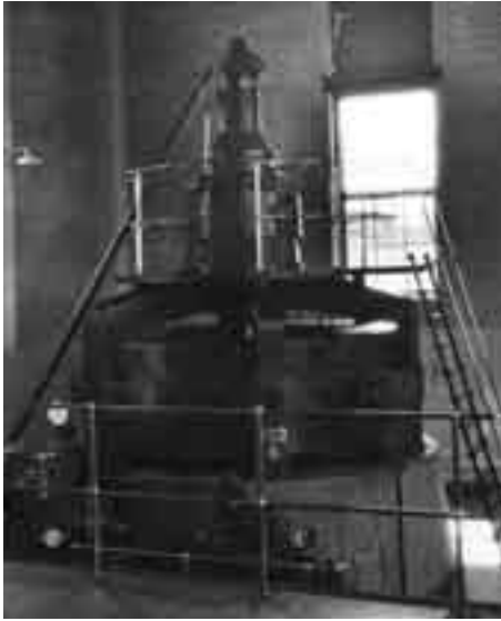
Holstebro Vandkraftværk set fra søsiden. Indvendigt ses den lodrette 850 hk Kaplan-turbine, der er særlig effektiv ved lave faldhøjder.
