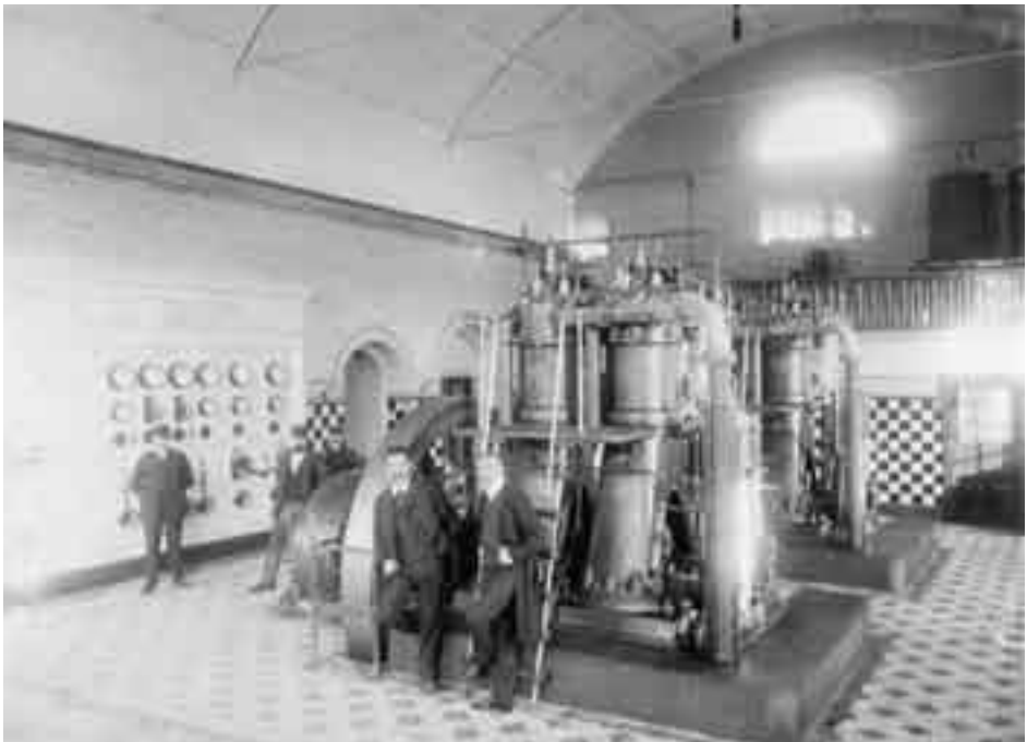
Interiør fra Nykøbing Falster kommunale elektricitetsværk med den stolte ingeniør P. A. Pedersen i forgrunden. Byrådsmedlemmet Frederik Graae beskrev ham som "...en glad, smilende mand med kulsort hår og øjne, der tydelig røbede afstamningen fra Napoleonskrigens berømte spaniolere...". Billedet udlånt af Elmuseet.
