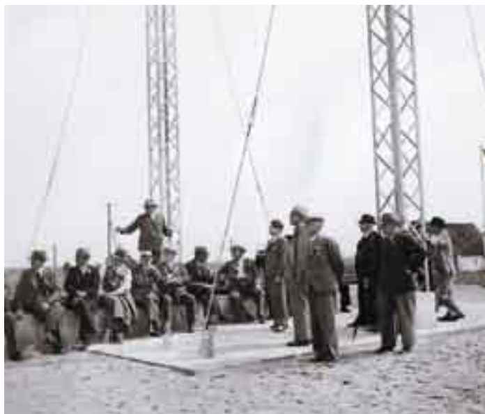
I 1941 var Vestjyllands samleskinne færdig, og her fremviser Stenild Hjorth et 60 kV anlæg i Videbæk for samleskinnens interesser.
