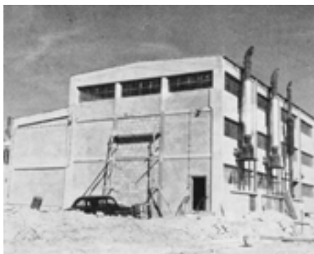
Højspændingsværket ved havnen i Latakia blev bygget som led i moderniseringen af byens havneanlæg.
